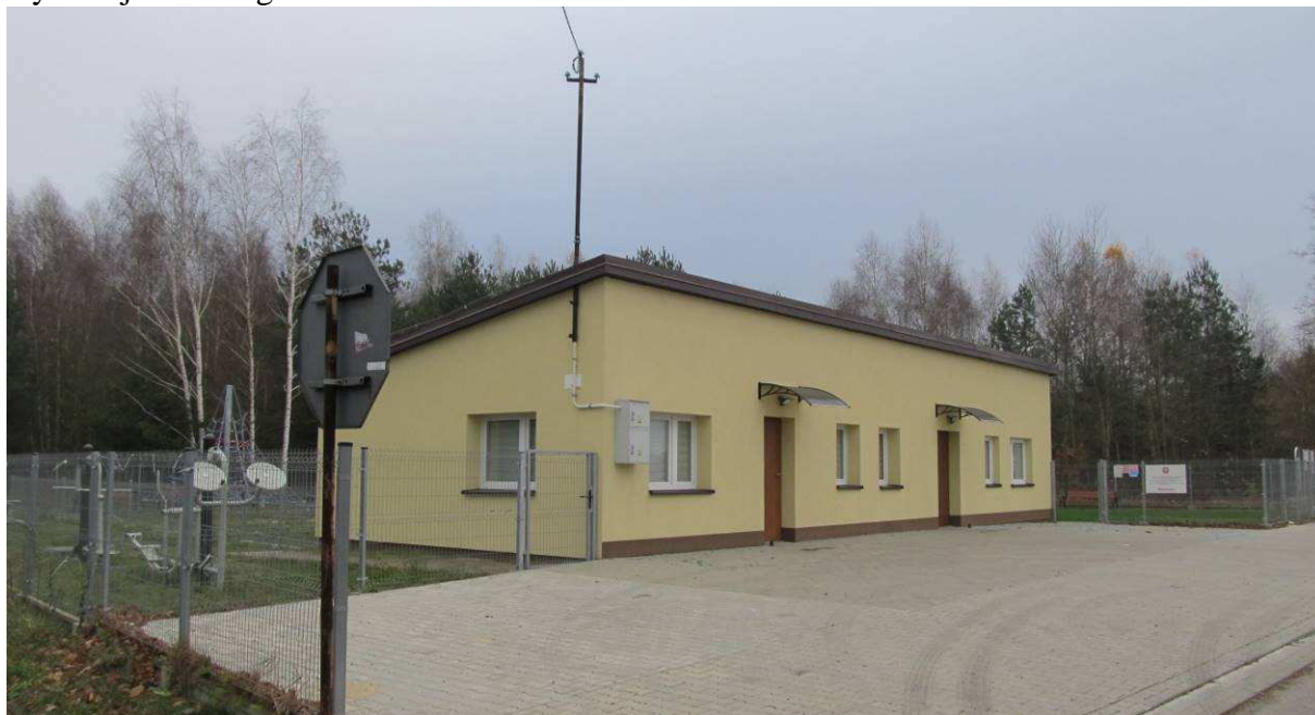
Zdj.14. Obszar IV – istniejąca zabudowa
