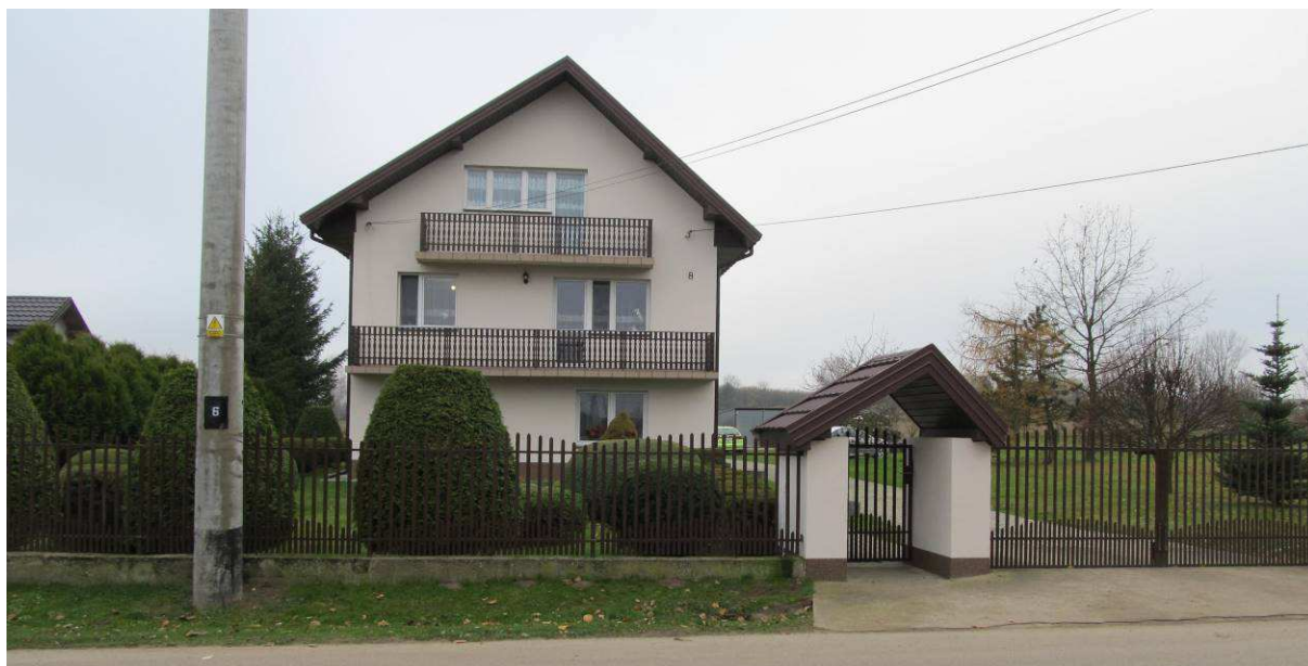
Zdj.1. Obszar I – istniejąca zabudowa
